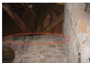
(photo 63) Chaînage du haut du clocher ayant maintenu la structure
