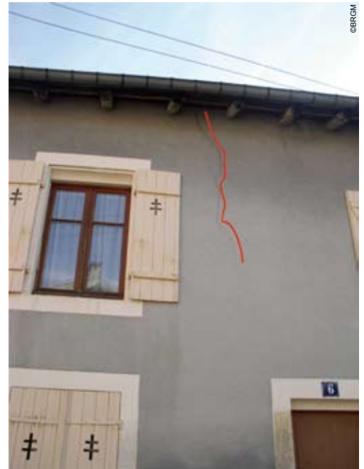
(photo 73) Fissuration large sur mur extérieur
