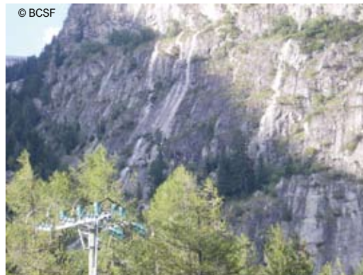
(photo 10) Traces de chute de pierres dues au séisme (dalles de Barberine à proximité de la frontière où l'alpiniste a été blessée).
