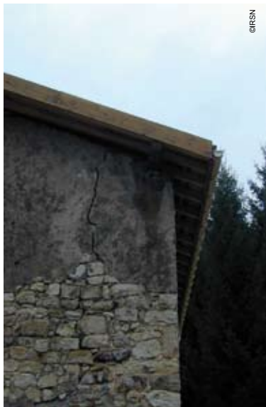
(photo 40) Frémifontaine (départ. 88) Maison évacuée, exemple de fissure sur un coin
