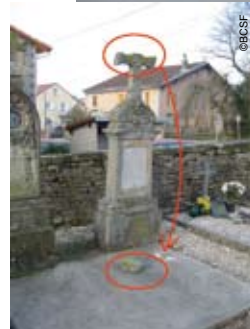
(photo 30) Destord Cisaillement de la croix d'une pierre tombale
