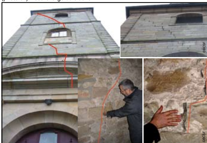
(photo 63) Chaînage du haut du clocher ayant maintenu la structure
