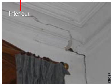
(photo 55) Fissuration large sur le remplissage de la voûte
