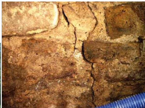
(photo 76) Bains-les-Bains - Intensité VI (dép. 88 - 35 km de l'épicentre) Fissurations sur maison particulière, atteignant les fondations selon le propriétaire (sans visite BCSF - images envoyées par le propriétaire)
