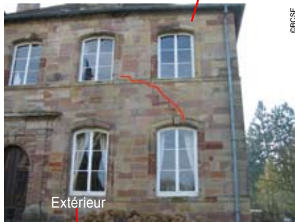
(photo 53) Fissurations entre murs et plafonds
