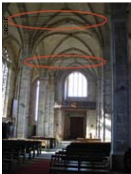
(photo 54) Tiges d'acier de renforcement des voûtes
