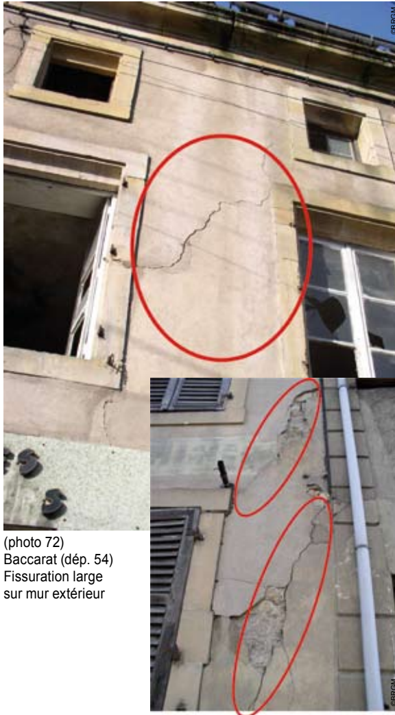
(photo 73) Fissuration large sur mur extérieur
