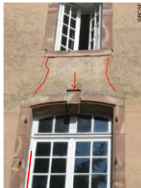
(photo 49) Façade sud, corps du bâtiment
